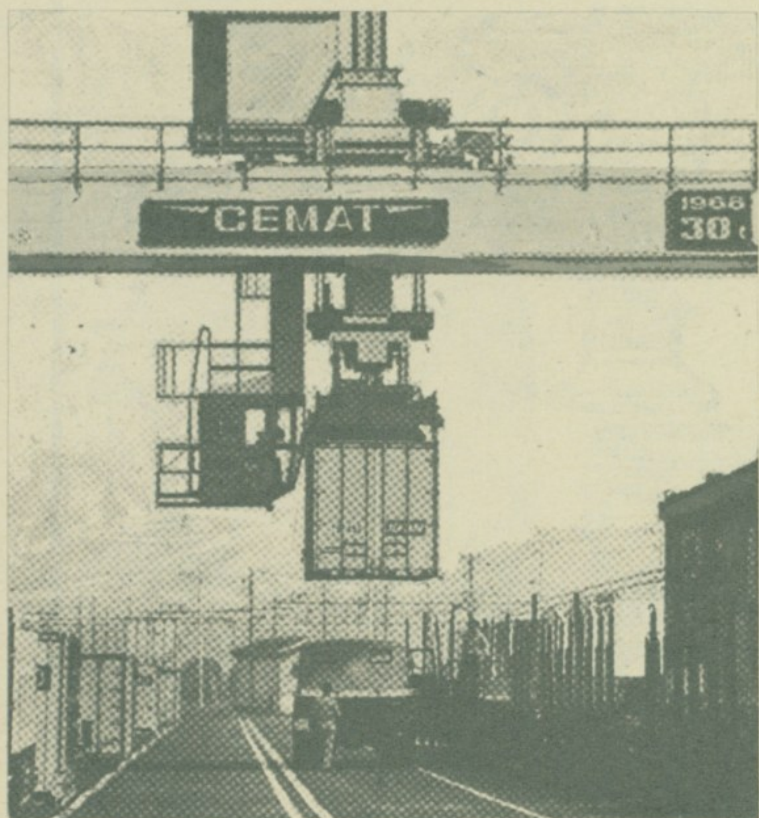
ЛУКЕ И ЖЕЛЕЗНИЧКЕ СТАНИЦЕ МОРАЈУ БИТИ СПЕЦИЈАЛНО ОПРЕМЉЕНЕ ЗА УТОВАР И ИСТОВАР КОНТЕЈНЕРА. НА СЛИЦИ ЈЕ МОСТ СА ДИЗАЛИЦОМ
