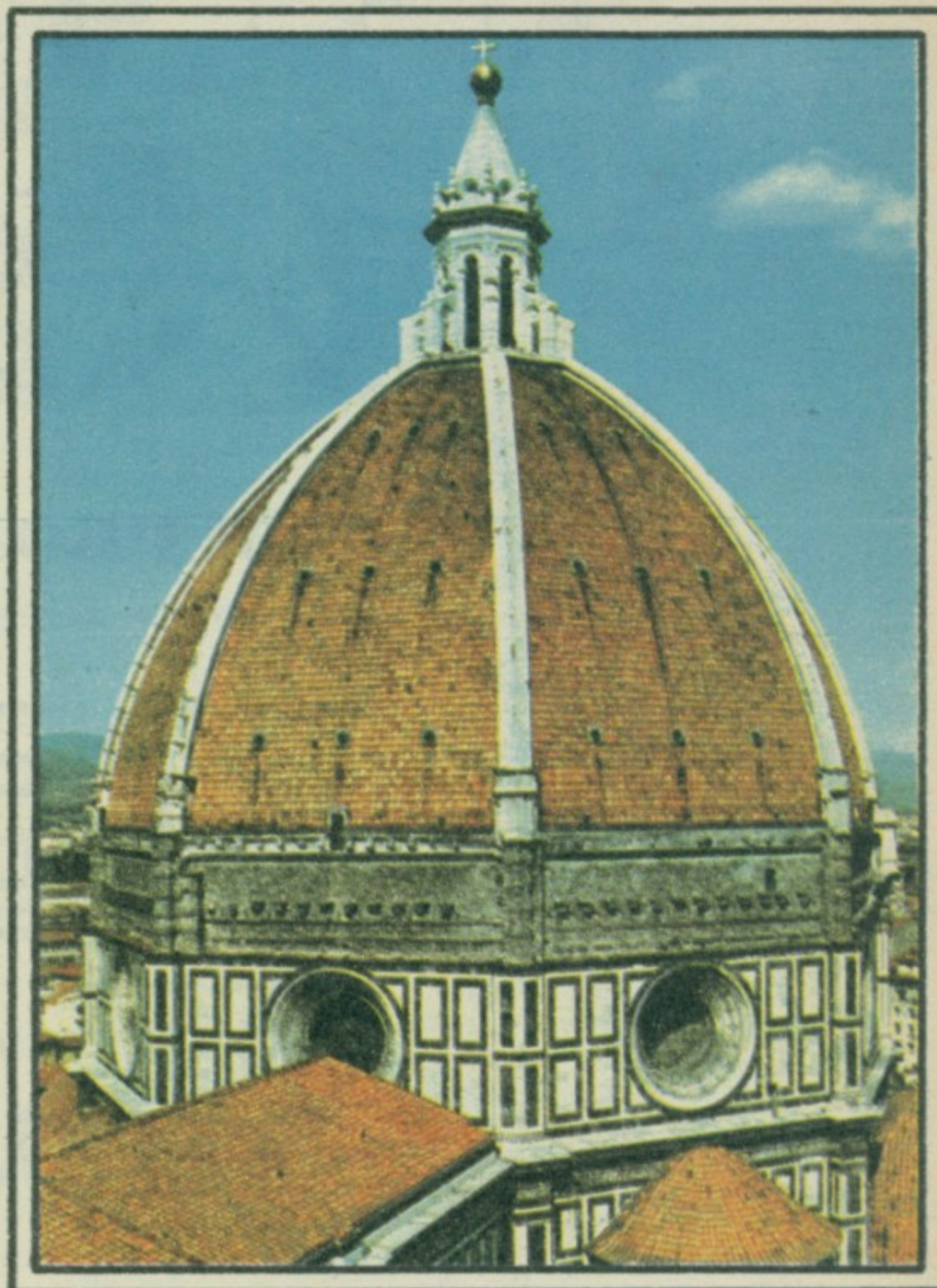
КУПОЛА КАТЕДРАЛЕ У ФИРЕНЦИ — На конкурс за изградњу куполе катедрале у Фиренци, најпознатији ренесансни архитекта Филипо Брунелески победио је између једанаест архитеката и купола је изведена по његовом пројекту. Замислио је да се купола држи на већ завршеној основи њомом својом масом без икаквог потпорног система. Купола је висока 107, а има распон од 42,3 метра. Иако су примењени нови системи грађења, купола је задржала старомодну форму. Ова купола је најпознатије Брунелескијево дело.
