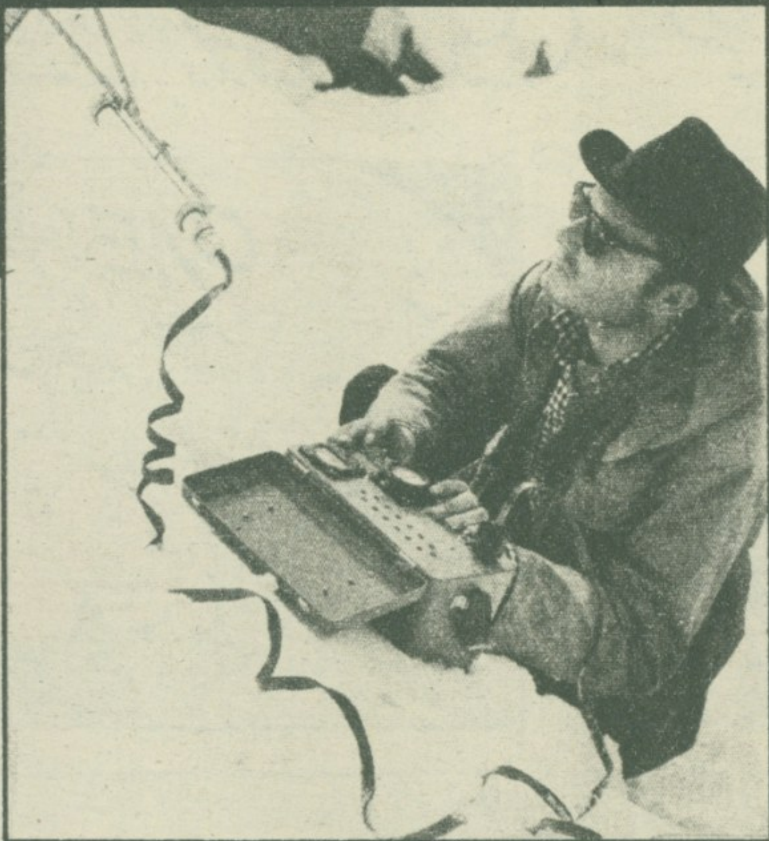
У Совјетском Савезу лавине су доста честе тако да мноштво стручних екипа ради на њиховом предвиђању и спречавању. На слици: мерење влажности снега.
