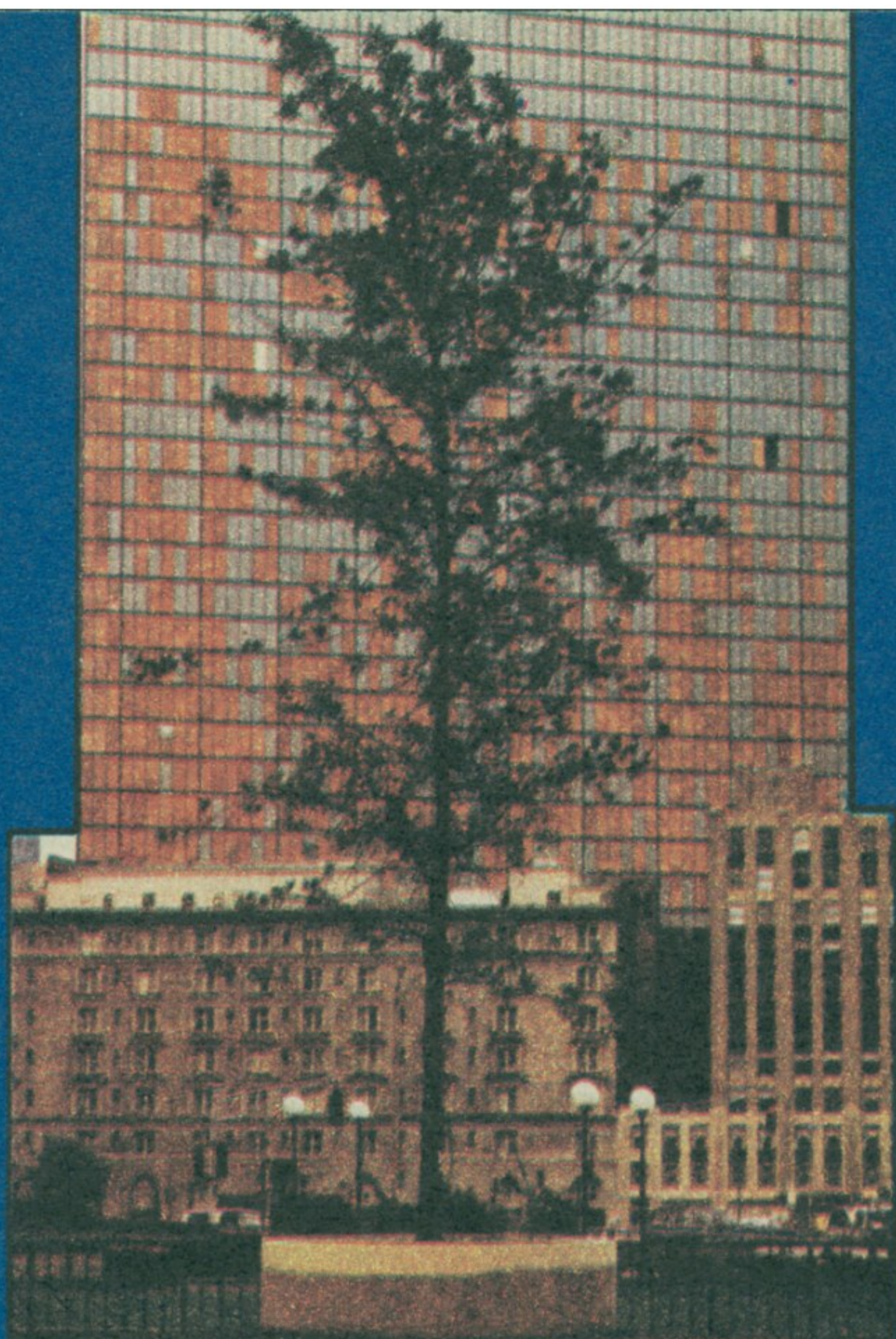
На бостонској згради „Џон Хенкок“ има 10.348 прозора. Услед јачег налета ветра 1970. године испало је 5 хиљада стакала. После тога сви прозорски оквири су
